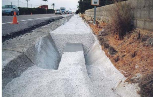
Figura Nº 9 : Dren filtrante. Esquema y ejecución (Fuente: Momparler, & Andrés-Doménech, 2008)
