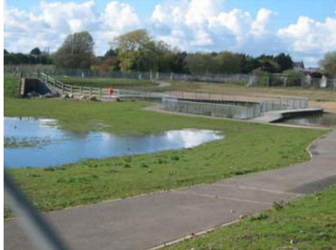
Figura Nº 11 : **Depósitos de infiltración** (Fuente: Momparler, & Andrés-Doménech, 2008)
