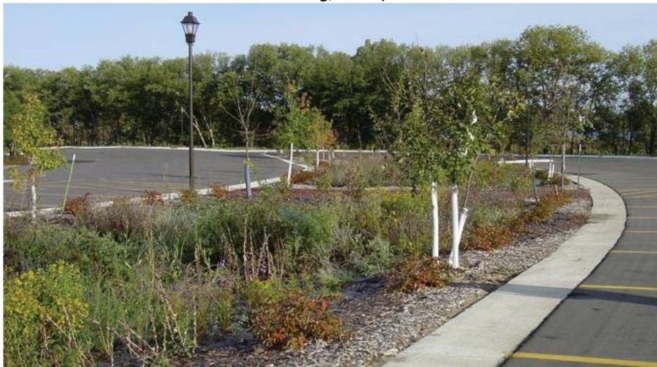
Figura N° 16: Celda de biorretención (Fuente: USDA, sf, tomado de Bennet, 2009)
