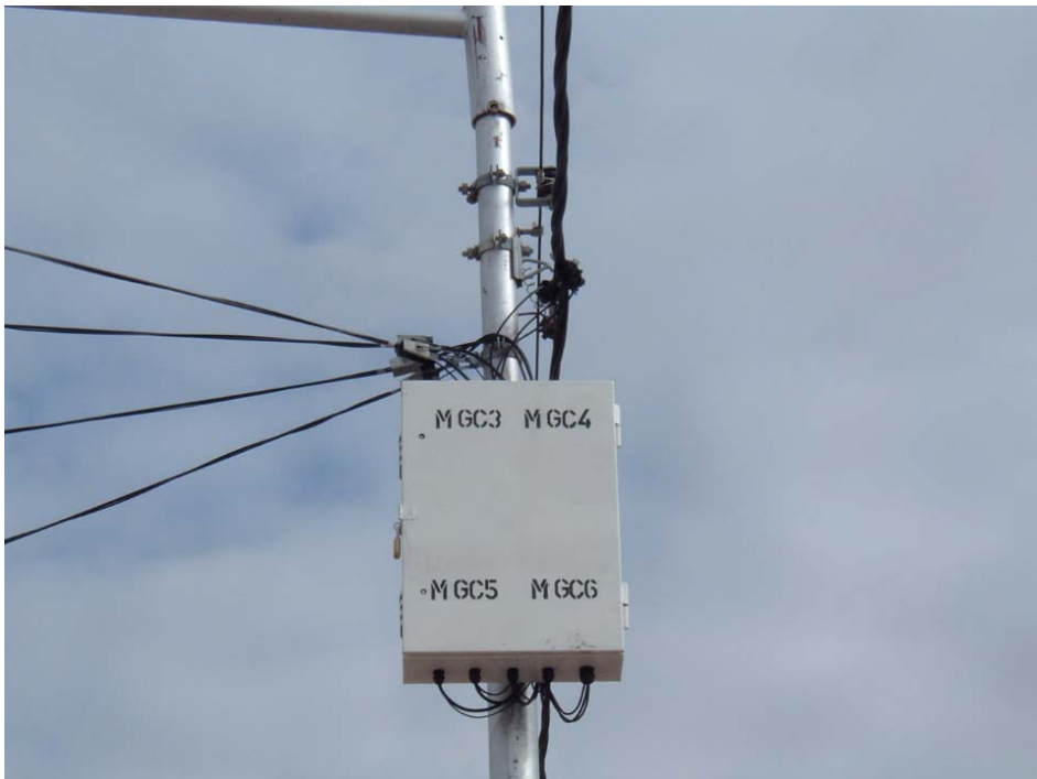
UBICACIÓN DE LAS CAJAS PERPENDICULARES A LA LÍNEA DE DISTRIBUCIÓN. DETALLE DE TENDIDO DE ACOMETIDAS.
