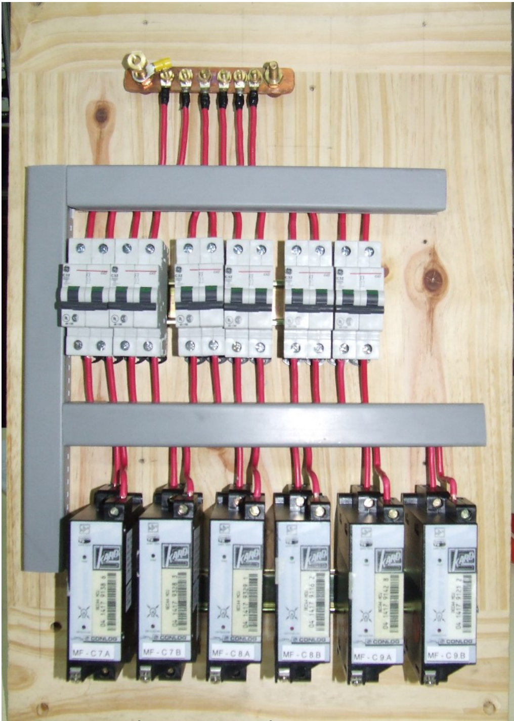
PROTECCIONES TERMOMAGNÉTICAS Y DISPENSADORES. CABLEADO, CONEXIONADO Y DISTRIBUCIÓN SOBRE LA MADERA DEL TABLERO. LAS FOTOGRAFÍAS SON SÒLAMENTE INDICATIVAS
