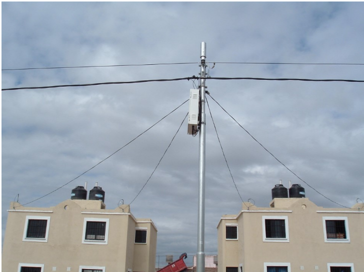
UBICACIÓN DE LAS CAJAS PERPENDICULARES A LA LÍNEA DE DISTRIBUCIÓN ACOMETIDAS DE VIVIENDAS TIPO DUPLEX. RETENCIÓN REALIZADA SOBRE LA PARED
