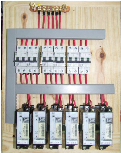
PROTECCIONES TERMOMAGNÉTICAS Y DISPENSADORES. CABLEADO, CONEXIONADO Y DISTRIBUCIÓN SOBRE LA MADERA DEL TABLERO. LAS FOTOGRAFÍAS SON SÒLAMENTE INDICATIVAS
