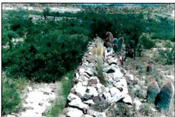
Fig. 105. Corrales Históricos de La Pintada, se observa la estructura de terminación piramidal de la pirca
