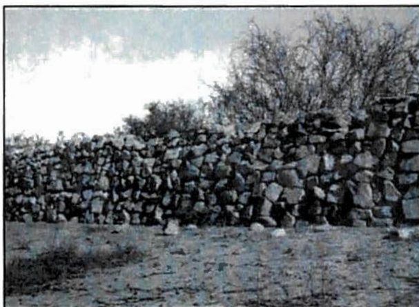
Fig. 112. La Pirca o pared sur de los Corrales de la Pintada , que tiene unos 2 m. de altura y que se conserva en muy buen estado. Foto tomada por el autor en 1957.
