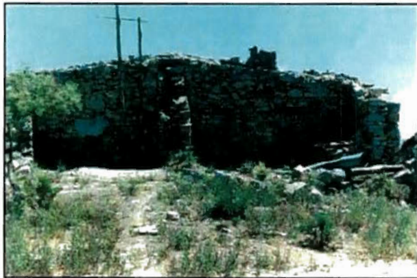
Fig. 114. Otra vista de la Casa de Los Goicos en La Pintada, 1994. Sector Este.
