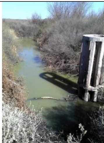
Fotografía 8: Obra de toma Canal Moyano
