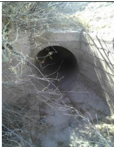
Fotografía 7: Alcantarilla D=1m Aliviadero de zona de retención
