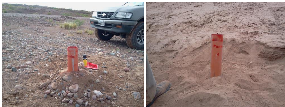
Imagen 4: Amojonamiento de puntos característicos
