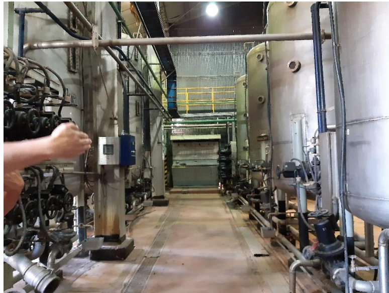
Fig.8 – Línea de Columnas de Intercambio – Planta de Concentración.
