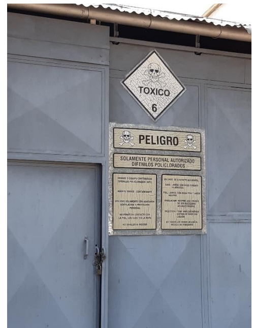
Fig.2 – Puerta de acceso al Depósito de Residuos Peligrosos.
