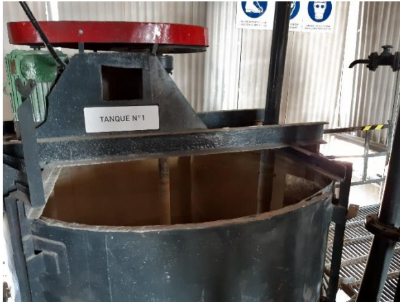
Fig.12 – Planta Neutralización – Tanque N°1. Fuente: Comisión Auditora FCAI.
