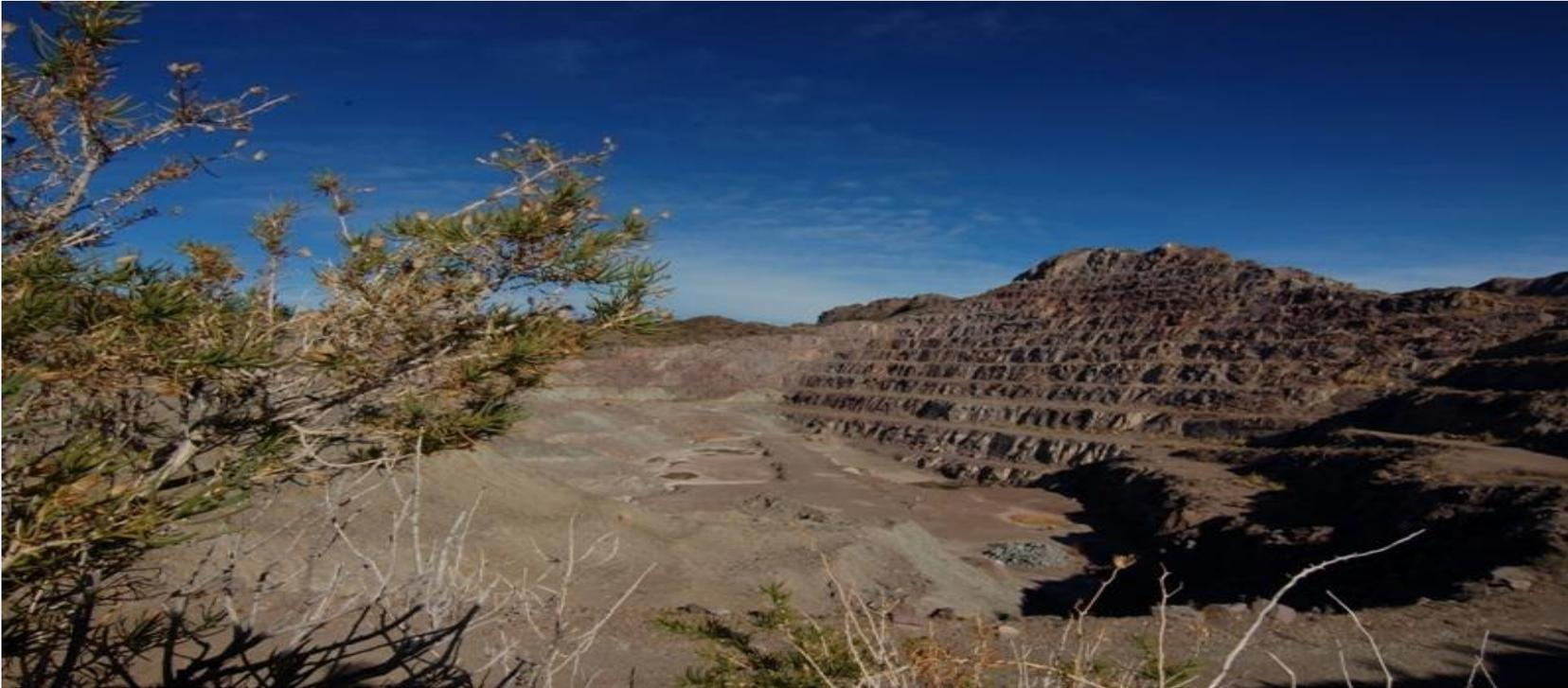
La extracción de la roca portadora de la mineralización se realizaba mediante una serie de etapas sucesivas: perforación, voladura, carga y transporte.
