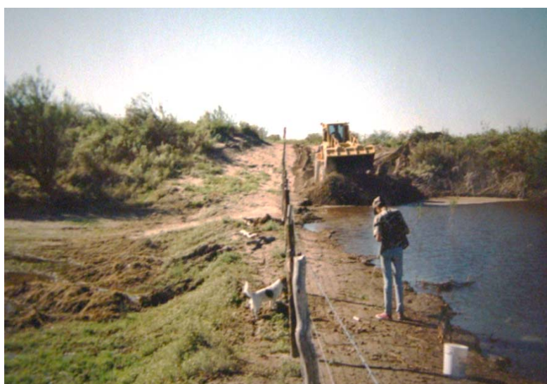
Fotografía 83: Terraplén que provoca el corte del escurrimiento del río, construido por un productor rural de la zona de Santa Isabel a efectos de realizar usos alternativos del agua y proteger su vivienda ubicada en zona de inundación. Cedida por el propietario (08/04/2011).
