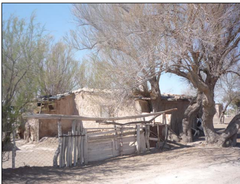
Fotografía 42: Puesto construido con “chorizo” en Paso Maroma. M. Eugenia Comerci (2010).
