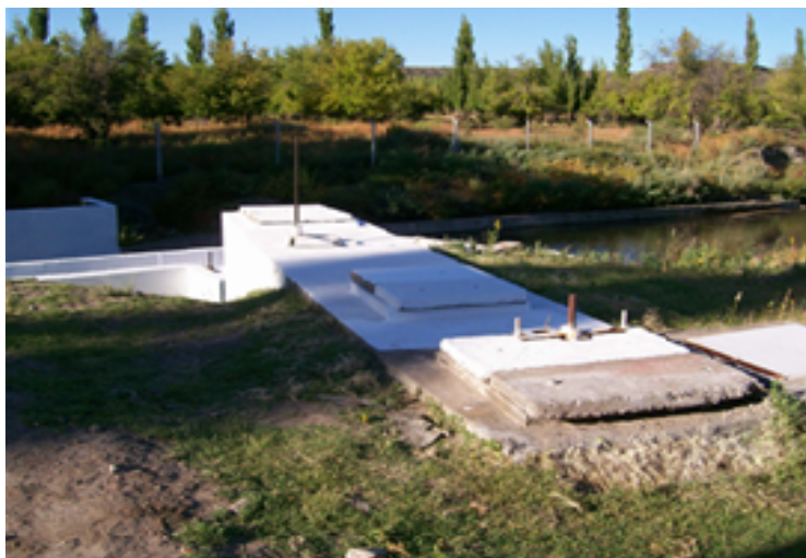
Fotografía 85: Toma de agua en Punta del Agua (Mendoza), inicio del Acueducto. Julieta Soncini (08/04/2011)
