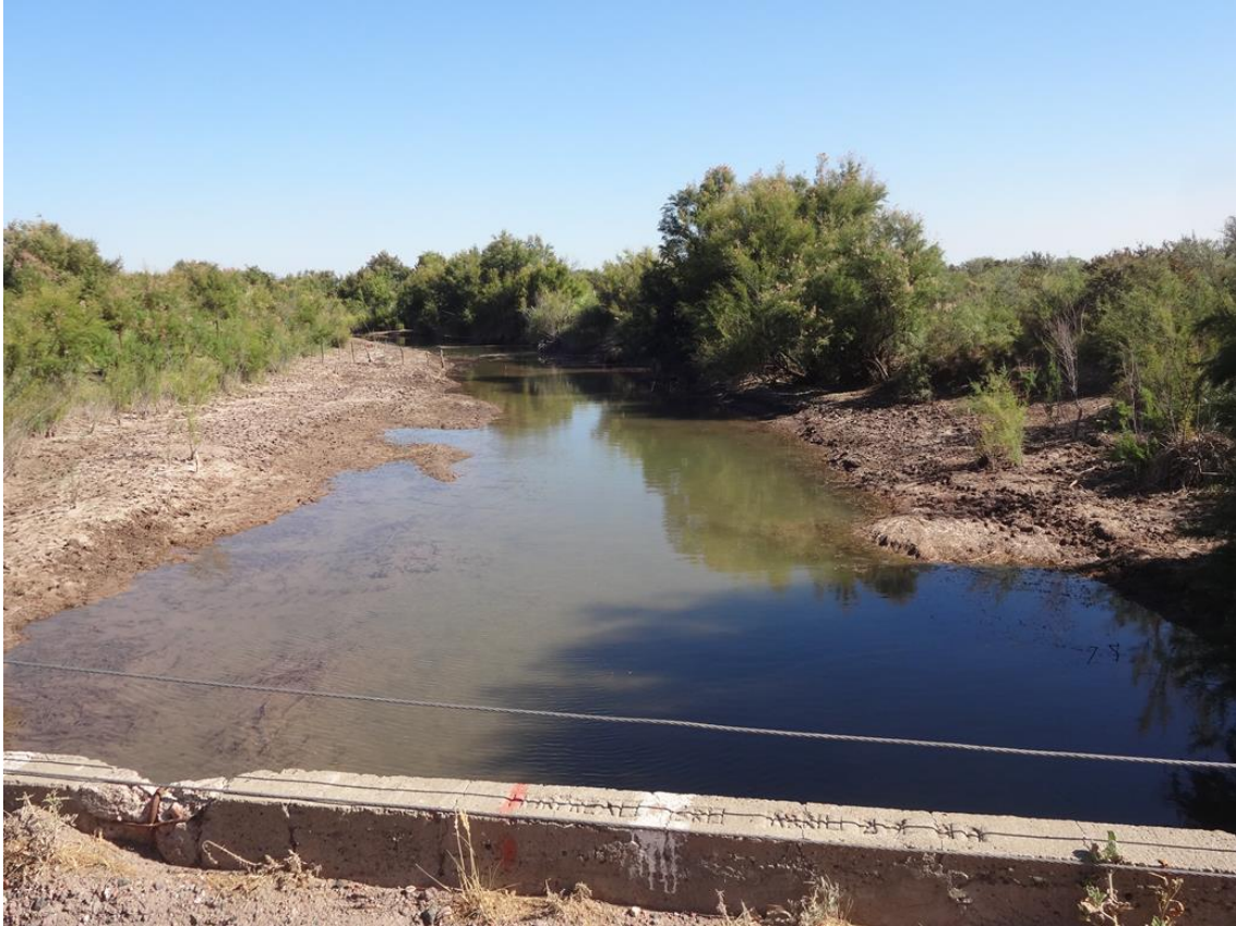
Imagen 23: Fecha de toma: 29-01-2018 / Lugar: Puente La Puntilla / Coordenadas: 36°15'33.45"S; 67°10'42.68"O.
