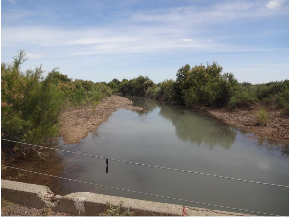
Imagen 21: Fecha de toma: 04-01-2018 / Lugar: Puente La Puntilla / Coordenadas: 36°15'33.45"S; 67°10'42.68"O.
