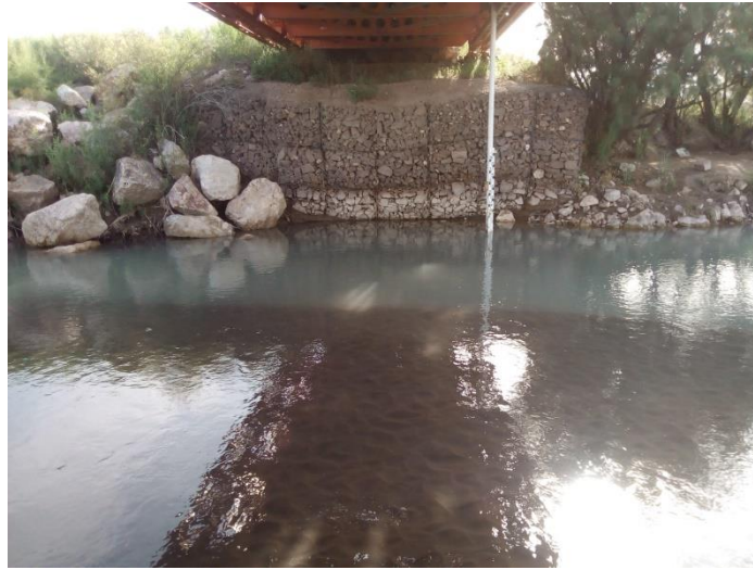
Foto 4: Vista de la sección de aforo en el puente Vinchuqueros
