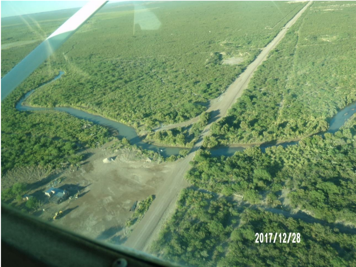
Imagen 20: Fecha de toma: 28-12-2017 / Lugar: Puente La Puntilla / Coordenadas: 36°15'33.45"S; 67°10'42.68"O.
