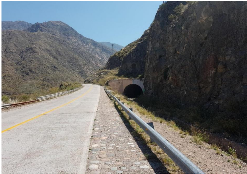
Vista de la losa de hormigón a demoler en Portal Sureste.
