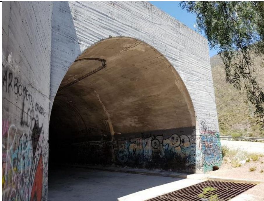
Estado actual del Portal Noroeste del Túnel N°1
