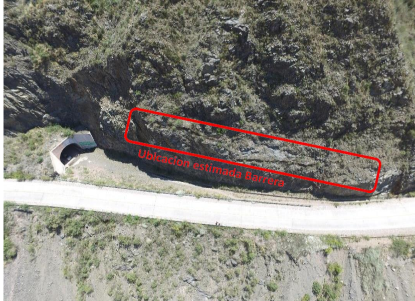
Zona de Instalación de barrera dinámica
