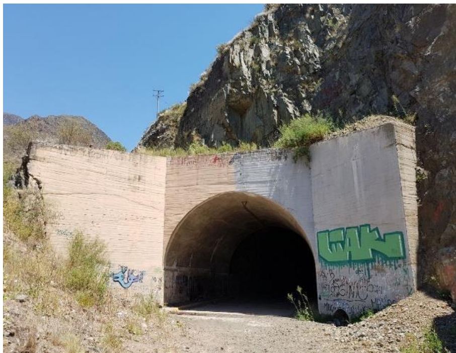
Estado actual del Portal Sureste del Túnel N°1
