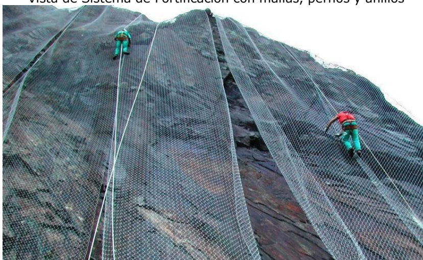
Instalación de malla colgada
