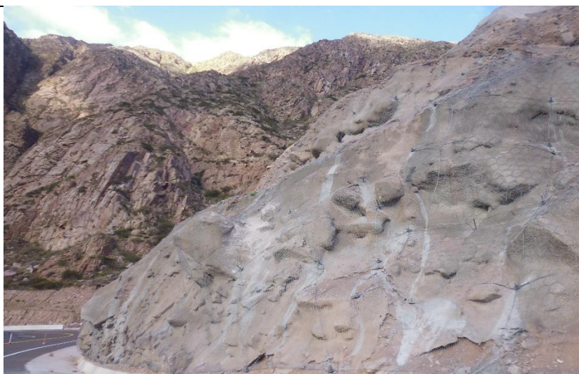
Vista de Sistema de Fortificación con mallas, pernos y anillos
