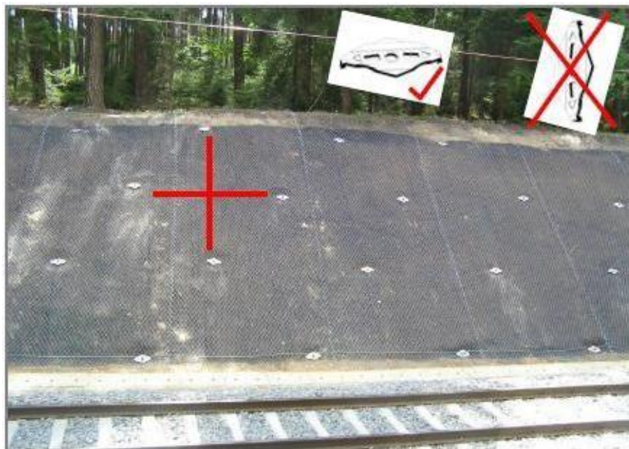
Ejemplo de colocación de Pernos Helicoidales
