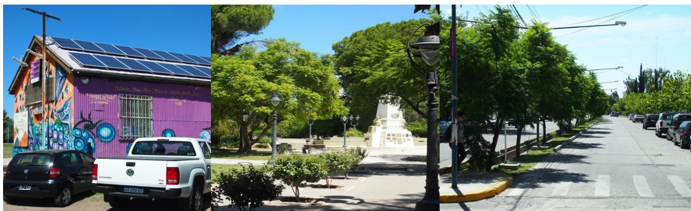
Instalaciones del alumbrado público del municipio.
