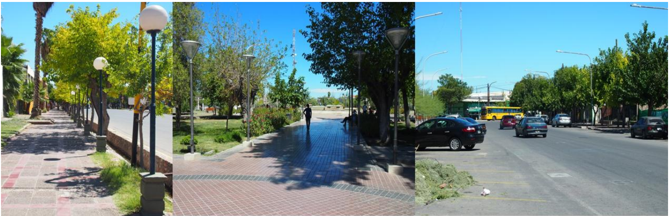
Instalaciones del alumbrado público del municipio.
