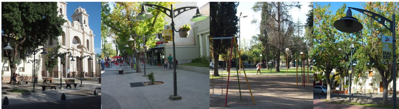
Instalaciones del alumbrado público del municipio.
