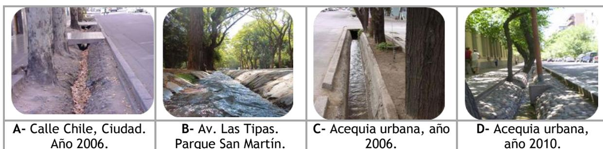
**Figura 5:** Sistema de riego del arbolado urbano de Mendoza: distintas tipologías y materialidad de las acequias de riego. A- Acequias de tierra de la época colonial; B- Acequia de cantos rodados ensamblados con tierra; C- Acequia de hormigón armado completamente impermeable; D- Acequia revestida con piedra fijada con cemento. Fuentes: Municipalidad de Capital y archivo del autor.
