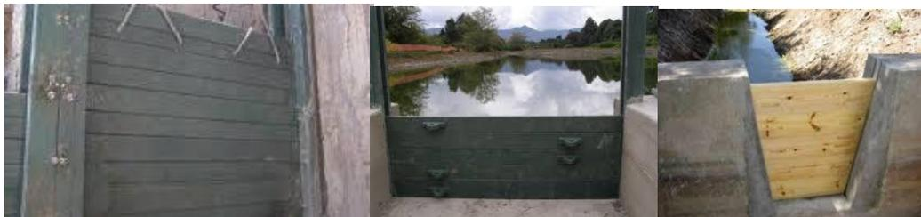
**Figura 2: Compuerta conformada por etapas o tramos**
