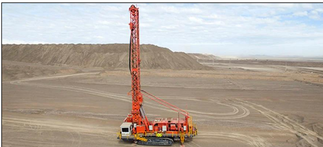
Fotografía 20.6 Vista de una máquina perforadora rotativa para perforación con aire reverso
