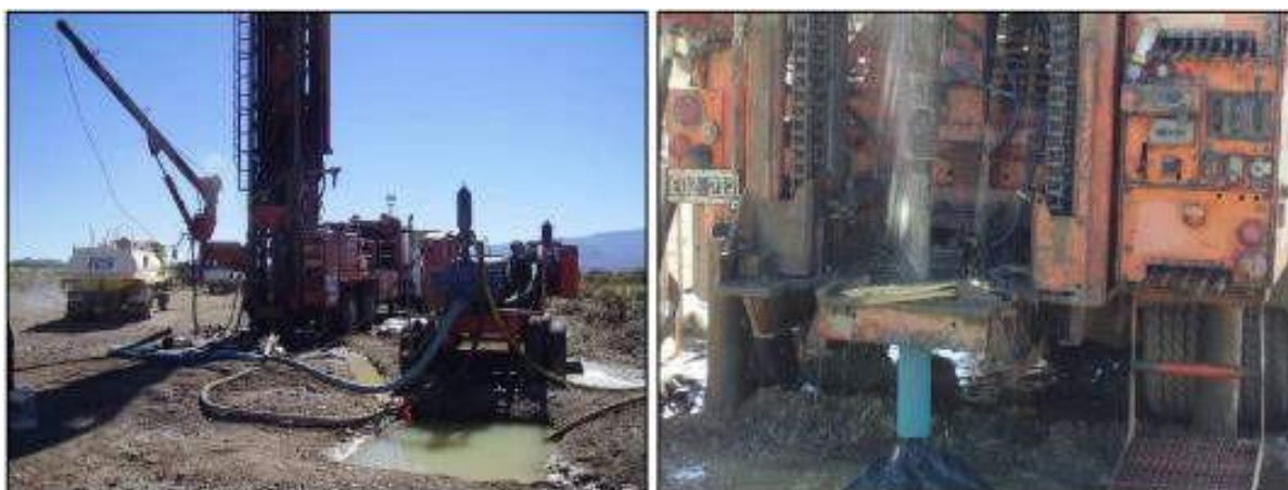
Fotografía 9.7 y Fotografía 9.8 Detalle de las tareas de perforación correspondientes al pozo SJ_PM_3
