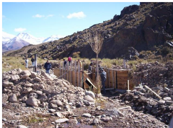
Fotografía 5-1. Vista de la construcción del aforador sobre el A° El Tigre (2007)
