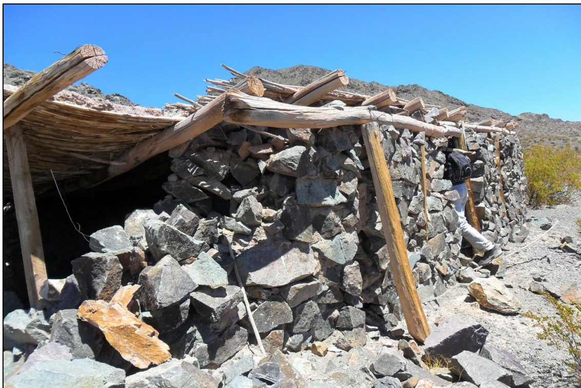
Figura N° d.6: antiguo campamento minero en la zona del RMDE.
