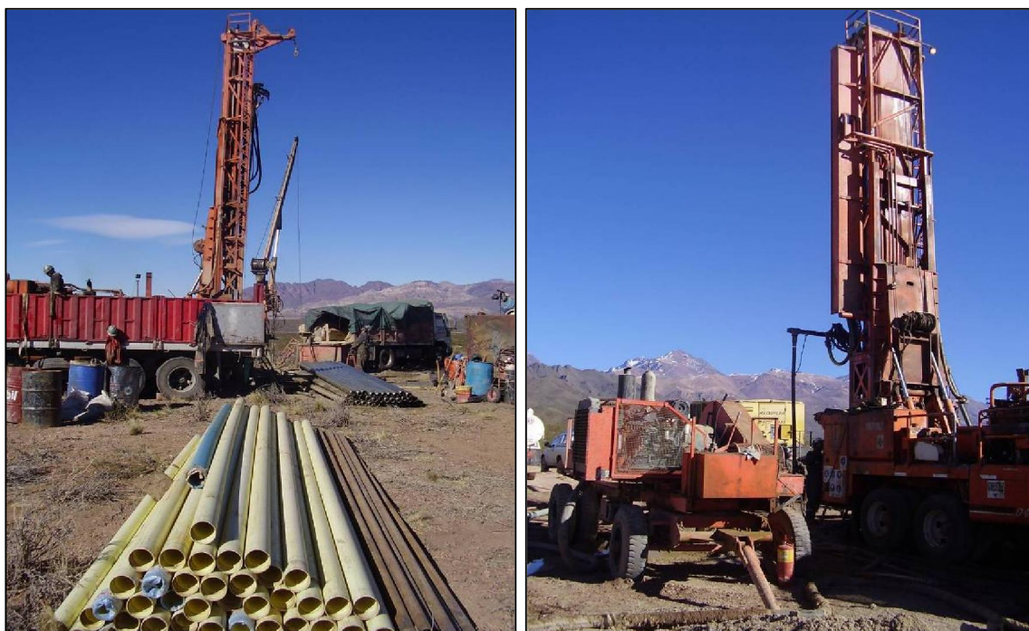
Fotos 8 y 9: detalle de las tareas de perforación correspondientes al pozo SJ_PM_4. Se aprecian caños de entubación (imagen izquierda) y la torre de perforación junto a un equipo generador de electricidad (fotografía derecha).
