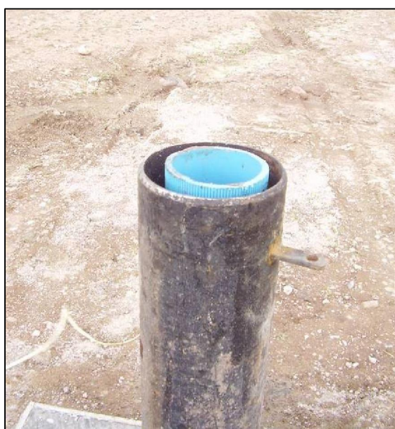
Fotos 2 y 3: detalle de las tareas de perforación correspondientes al pozo SJ_PM_1. La imagen de la izquierda corresponde a mediciones del nivel de agua en boca de pozo, registrándose un acuífero colgado a los 20 metros y el acuífero freático a los 50,68 m. La fotografía de la derecha muestra en detalle el caño de protección de superficie, de una longitud de 1.05 m y diámetro de 6 ½", con el soporte para asegurar la tapa. En su interior se observa la cañería PVC de 4".
