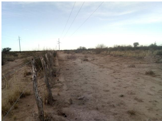
Fotografía 11: Línea de Alta Tensión dentro del predio. Vista este desde portal de ingreso.
