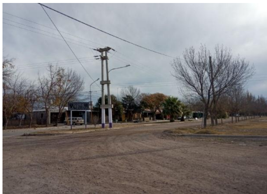
Fotografía 1: Barrio La Primavera, calle 21 de setiembre. Vista Oeste.
