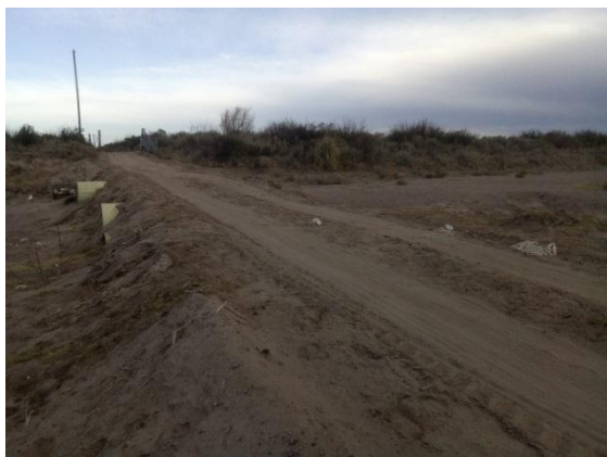
Fotografía 3: Cruce sobre cauce del Río Tunuyán. Vista Sur
