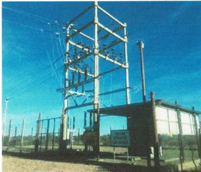
Fotografía 4.1 Punto de maniobra Pórtico. Fuente Energía Renovable Armonía SA.
