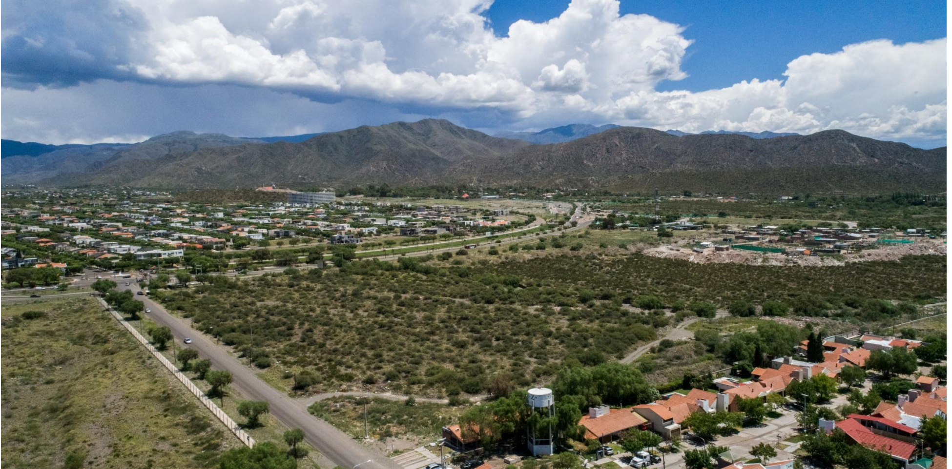
Figura N°10: Vista aérea del sitio del proyecto y zona de influencia.
