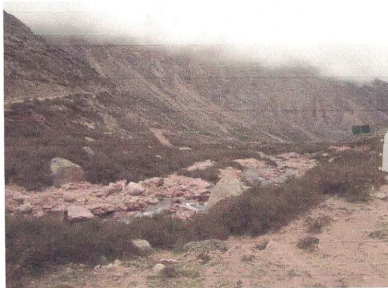
Figura 2. Trazado de nuevas vías de acceso al emprendimiento por parte de la Empresa.
