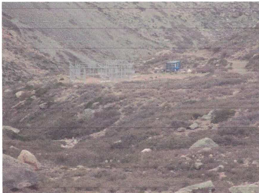
Figura 24. Construcción metálica correspondiente al Clubhouse.
