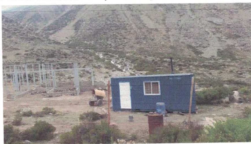
Figura 3. Vista de estructura metálica y obrador implantados en el terreno.
