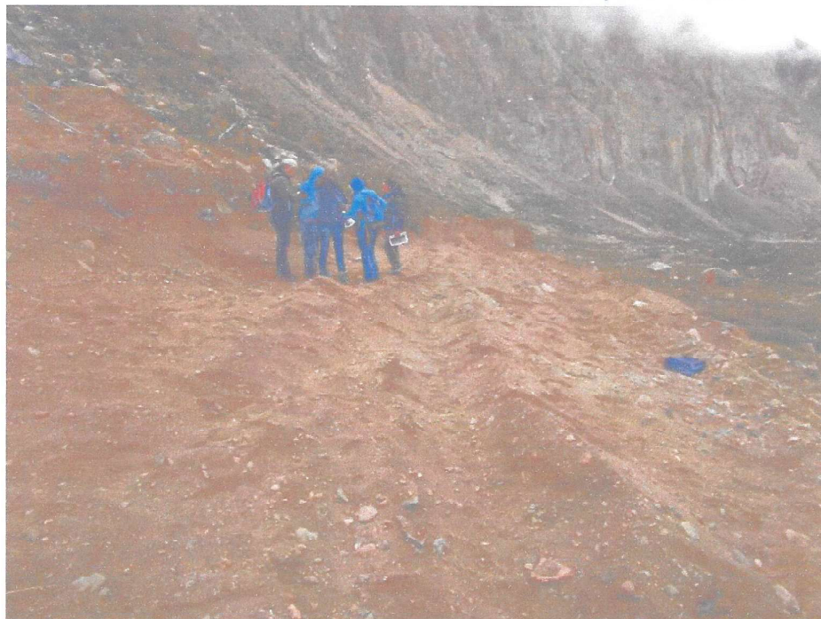
Foto 2. Trazado de camino de acceso interno al emprendimiento.
