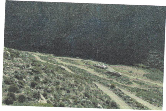
Vista desde la ubicación de cámara de carga hacia sala de máquinas
