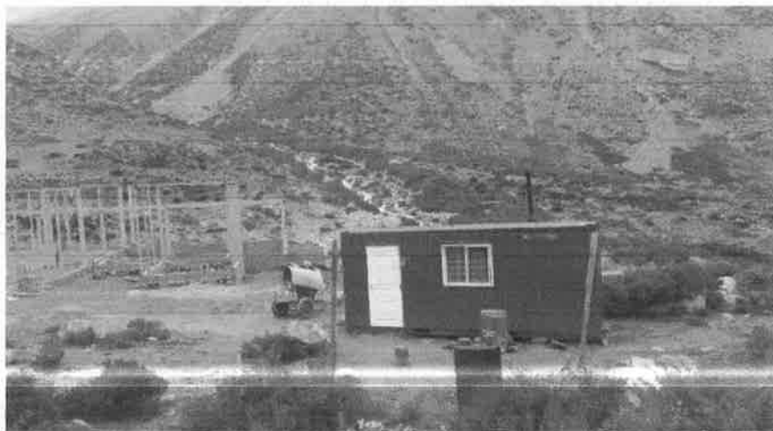
Figura 3. Vista de estructura metálica y obrador implantados en el terreno.
