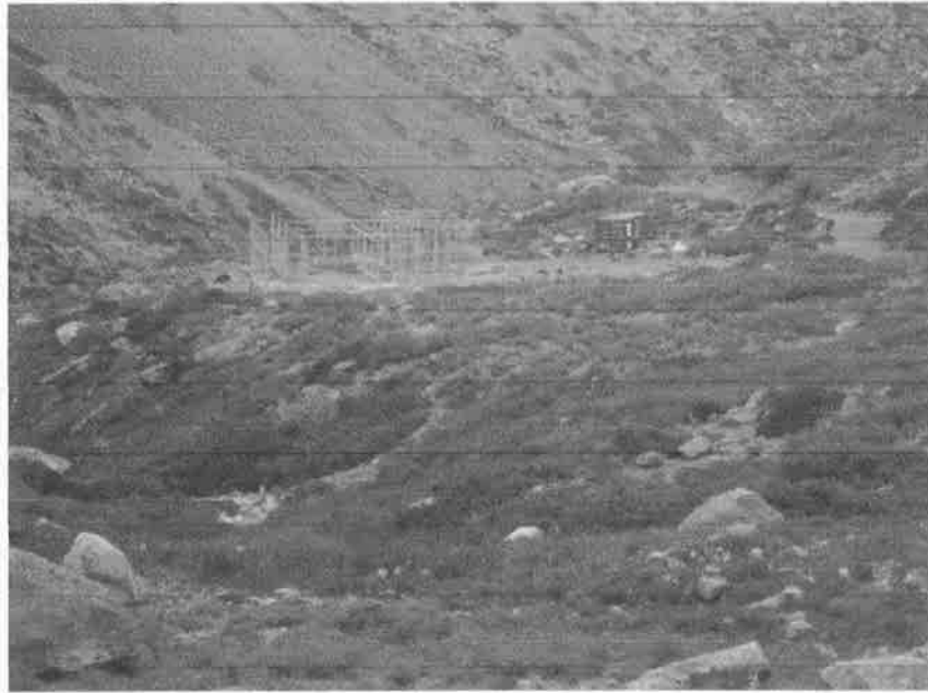
Figura 24. Construcción metálica correspondiente al Clubhouse.
