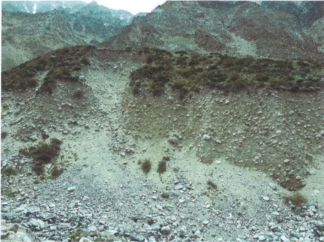
Figura 16: Colapsos por erosión en las barrancas de la margen izquierda del arroyo Grande.
