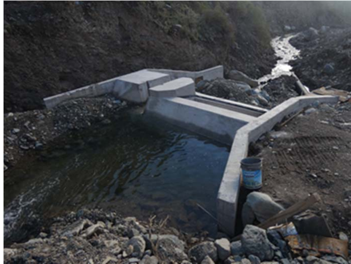
Imagen 5. Obra de captación construida.
