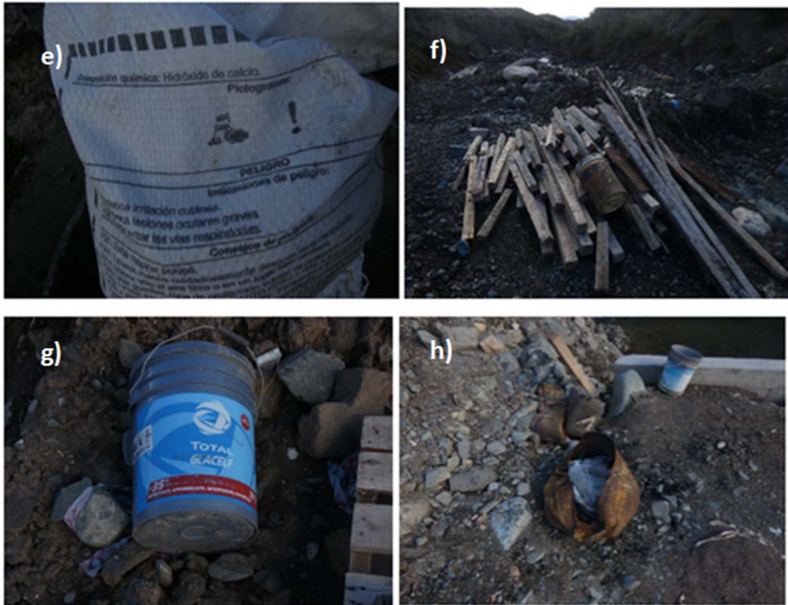
Imagen 7. a) manchas de aceite sobre talud, b) fogón con material plástico quemado, c, d, e, f, h) material de construcción (hierros, hormigón, maderas) mezclados con residuos: bolsa abierta de hidróxido de calcio, recipientes de lubricantes, anticongelantes, bolsas plásticas, chatarra, chapas.
