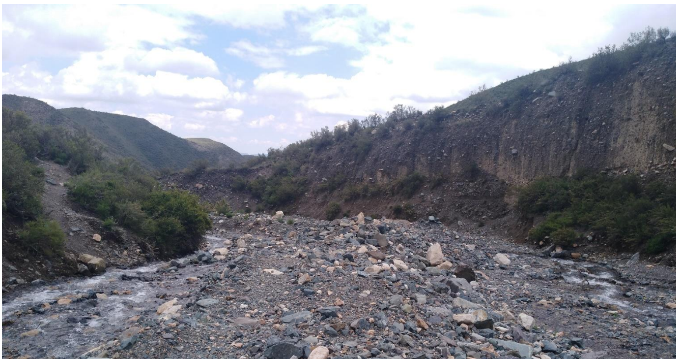
Fig. 6 Tramo de talud sin vegetación
