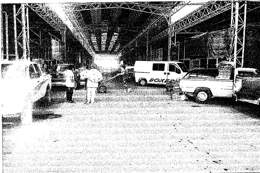
Foto N°3: locales frutihortícolas – sector de acceso vehicular para carga y descarga
