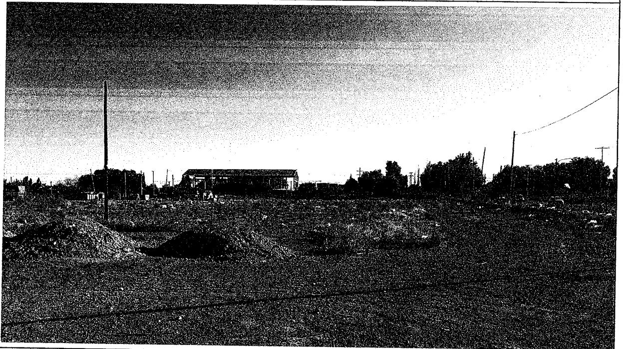
Foto 4. Vista desde el Límite Noroeste hacia el Interior del predio donde se ubicarán ampliaciones
