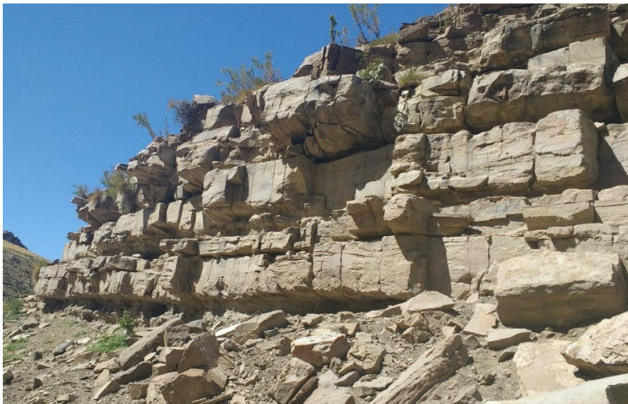
Figura 36. Ladera con bloques de rocas expuestos y caídas.
