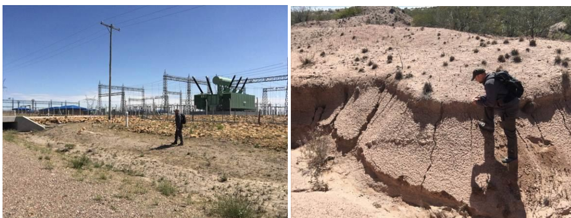
Figura 114. Fotografías de los trabajos de monitoreo paleontológico, sector área Estación Transformadora (Villa 25 de Mayo).
