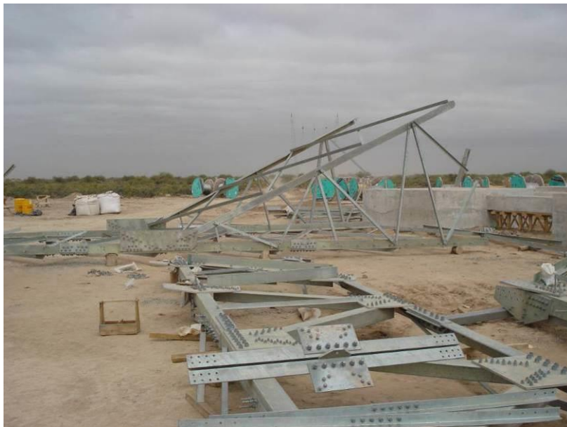
Figura 9. Armado de torres auto-soportadas. Foto ilustrativa
