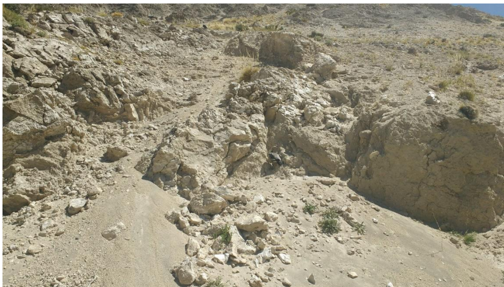
Figura 24. Ladera con procesos de remoción en masa, caída de bloques y deslizamientos.
