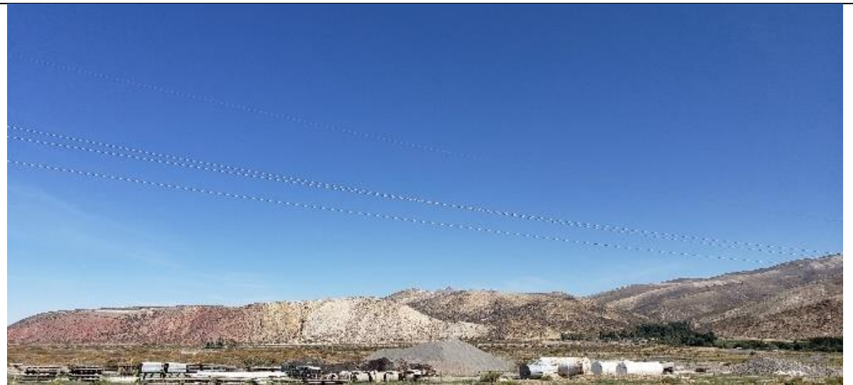
Diversas afectaciones del valle, especialmente con canteras de extracción de áridos, líneas eléctricas e instalaciones vinculadas a construcciones viales. Vista desde la RN40.
