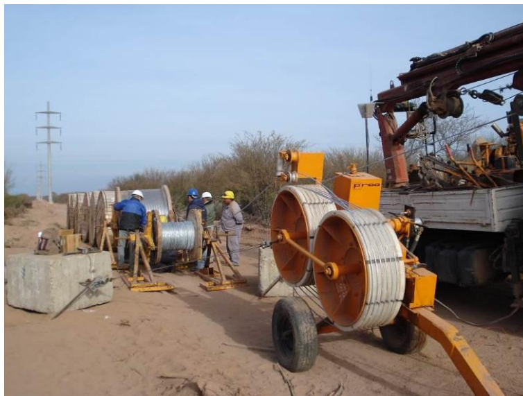
Figura 10. Ejecución de tendido de cables. Foto ilustrativa
