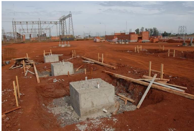
Figura 11. Construcción de bases de estructuras y kioscos en ET. Foto ilustrativa
