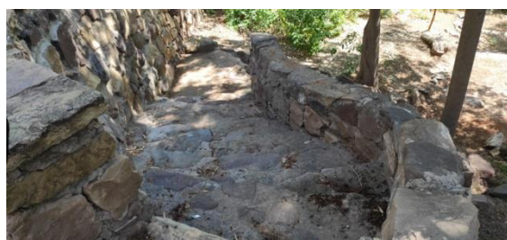
Foto 11: Sendero - escalera a reparar
