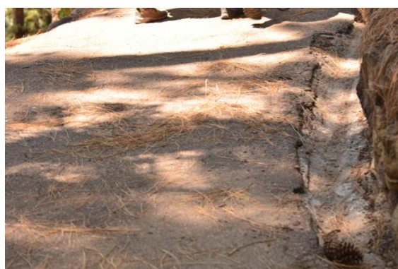
Foto 9: Detalle de acequias de drenaje pluvial en senderos
