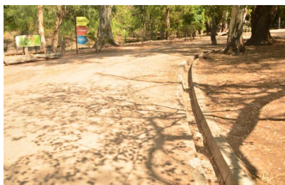
Foto 5: Desagües pluviales en senderos
