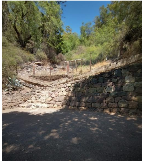
Fotografía N°5. Vista cauce y futuro badén en cuenca 403.
