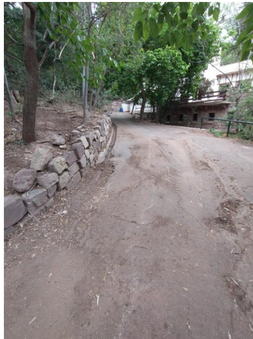
Fotografía N°10. Vista cuenca 405 sector donde se construirá un badén.
