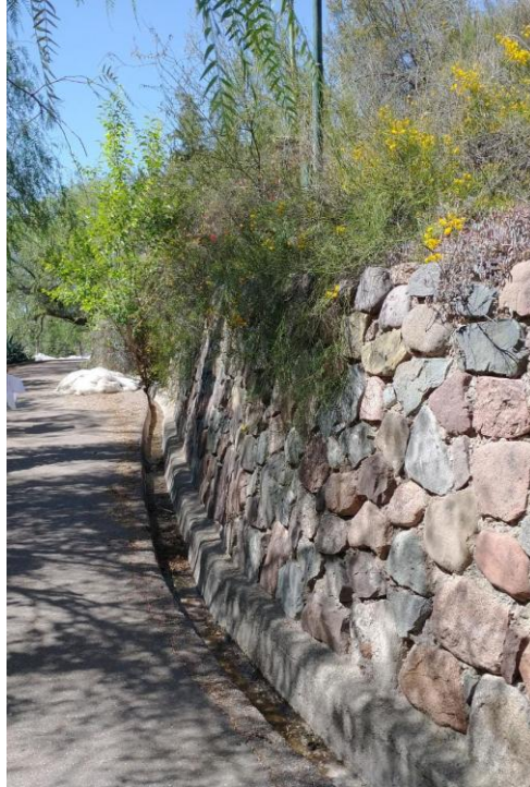
Fotografía N°7. Vista cuneta superior cuenca 404.
