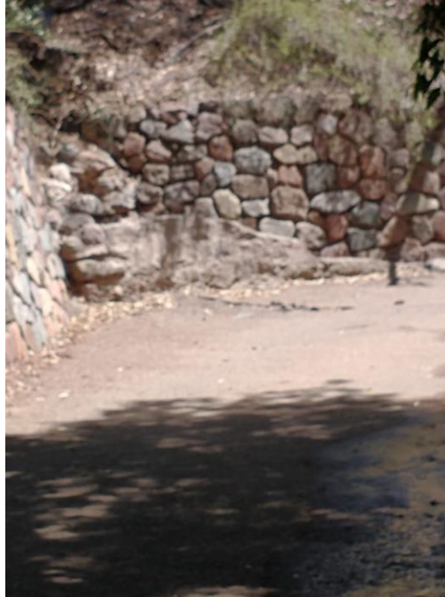
Fotografía N°3. Vista cuenca 403 Muro deflector a recrecer.
