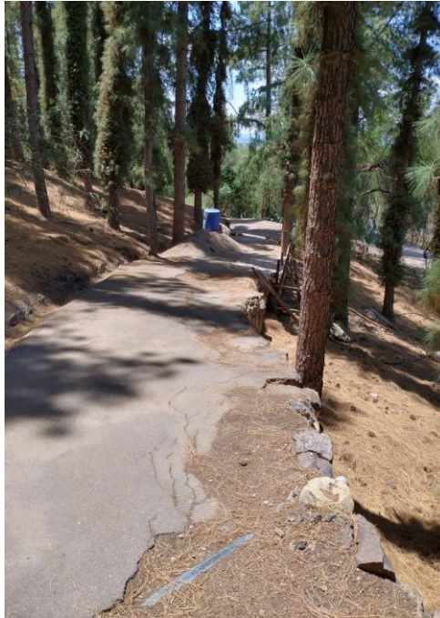
Fotografía N°1. Vista cuenca 401: Sector donde se construirá acequia en hormigón
