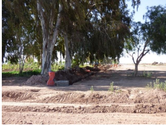
Foto N° 4: Ingreso a la planta de tratamiento. Personal trabajando en obra.
