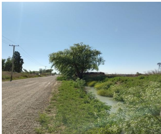
Foto N°3: Cauce paralelo a Calle R. S. Peña.
