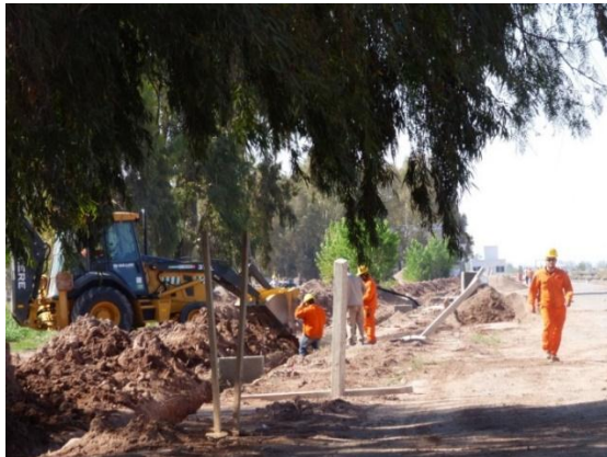
Foto N° 5: Personal trabajando en obra con máquina excavadora.
