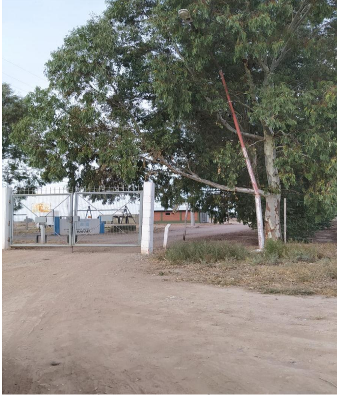
Imagen N° 1: Entrada a la Planta Depuradora Cuadro Nacional.
