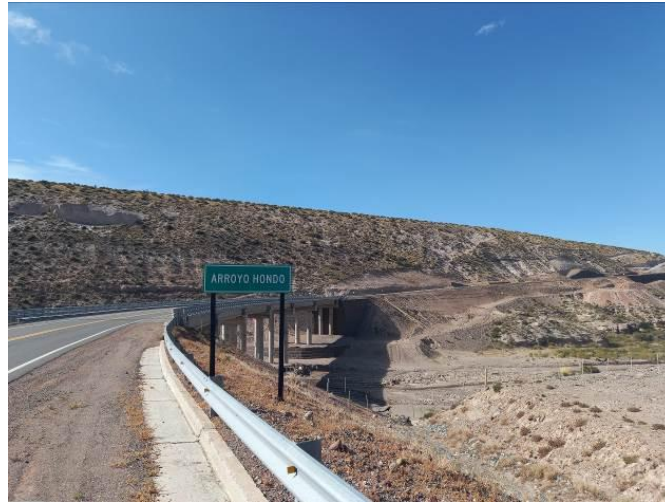
Figura 3. Peligrosidad Geológica de la zona de proyecto. Cauce aluvional A.Hondo
