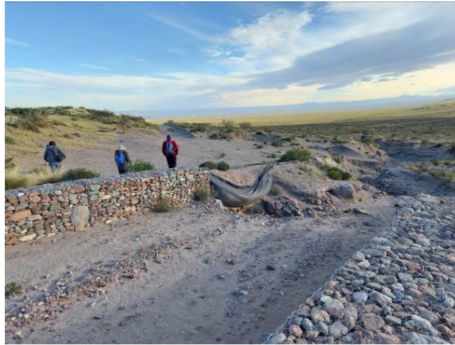
Figura 7. Peligrosidad Geológica de la zona de proyecto. Obra de protección con gaviones en salida de alcantarilla a cauce aluvional RNN°40
