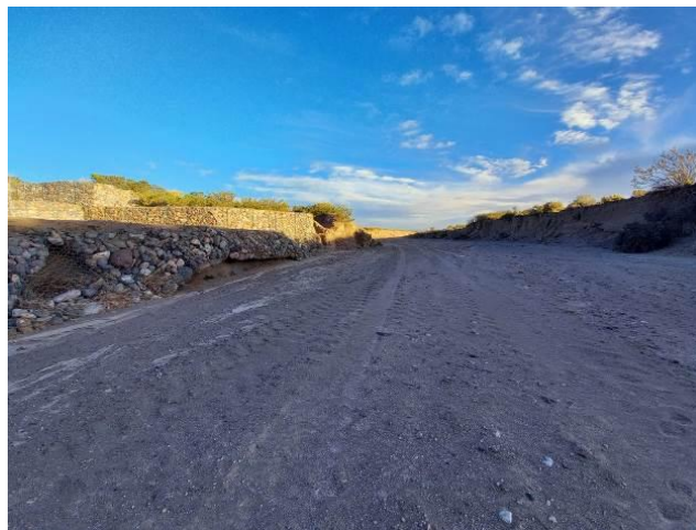
Figura 8. Peligrosidad Geológica de la zona de proyecto. Obra de protección con gaviones salida a RNN°40
