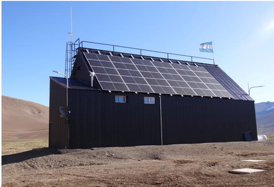
Figura 49. Galpón soporte de paneles solares.
