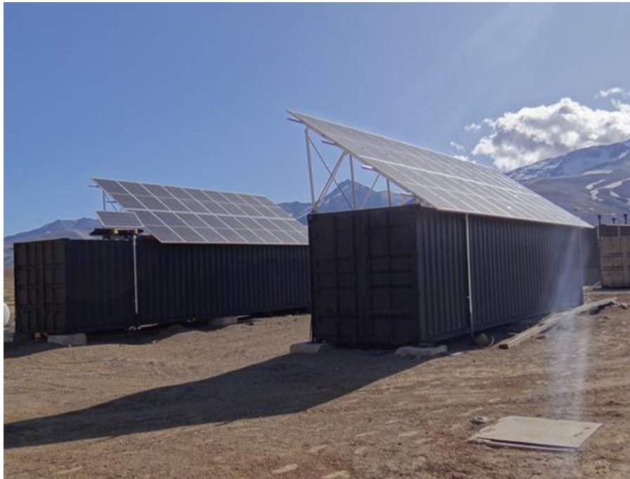
Figura 50. Contenedores para guardado de equipos y herramientas.
