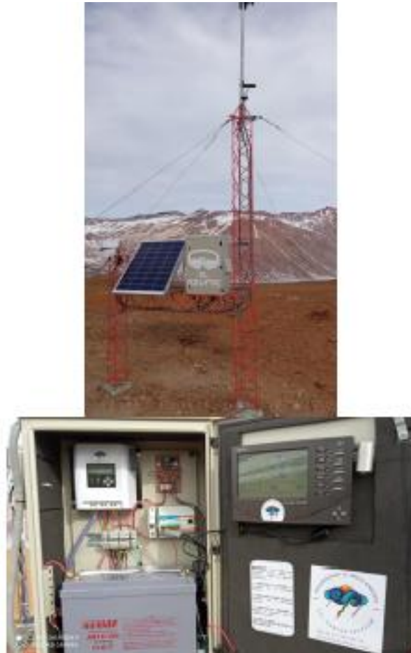
Figura 114. Vistas de la Estación Meteorológica El Azufre, julio 2021.
