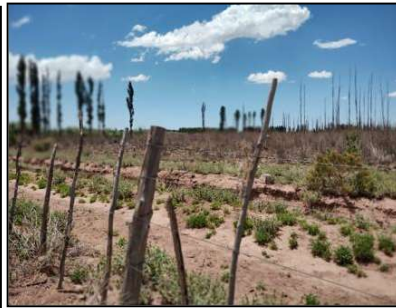
Foto N° 2 Vista al sitio a construir el Reservoirio N° 2
