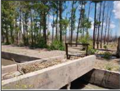
Foto N° 1 Vista al sitio a montar la sala de maquina
