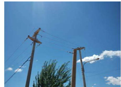
Foto N° 9 Vista al sitio donde se conectará la línea eléctrica
