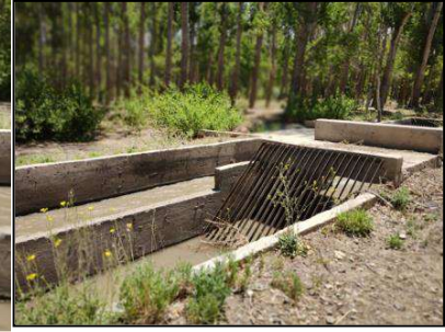
Foto N° 6 Vista al sitio a montar la sala de maquina
