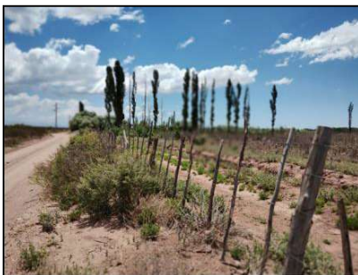
Foto N° 1 Vista al sitio a construir el Reservoirio N° 2
