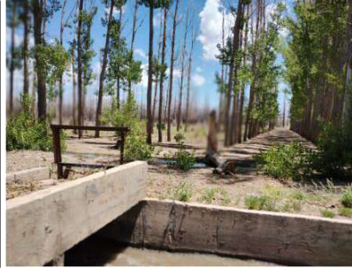
Foto N° 2 Vista al sitio a montar la sala de maquina
