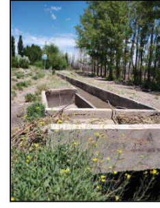
Foto N° 3 Vista al sitio a montar la sala de maquina
