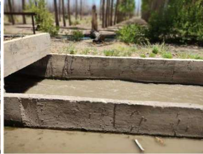
Foto N° 5 Vista al sitio a montar la sala de maquina
