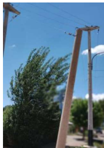
Foto N° 7 Vista al sitio donde se conectará la línea eléctrica
