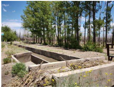
Foto N° 4 Vista al sitio a montar la sala de maquina
