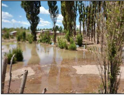
Foto N° 1 Vista al sitio a construir el Reservoirio N° 1
