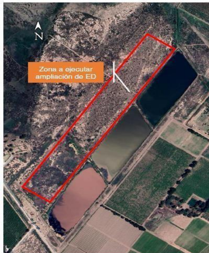
Figura 1. Foto aérea Establecimiento Depurador Palmira
