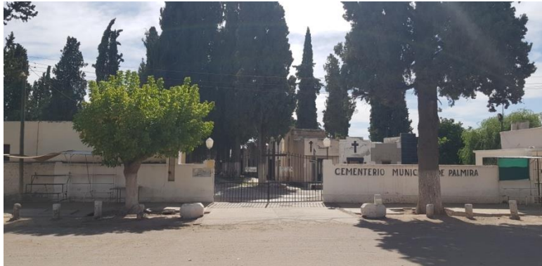
Foto N°18: Vista desde el cementerio hacia el terreno donde se proyecta la planta.
