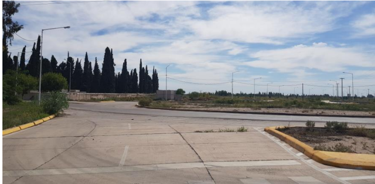
Foto N° 6: Vista del terreno hacia el Este
