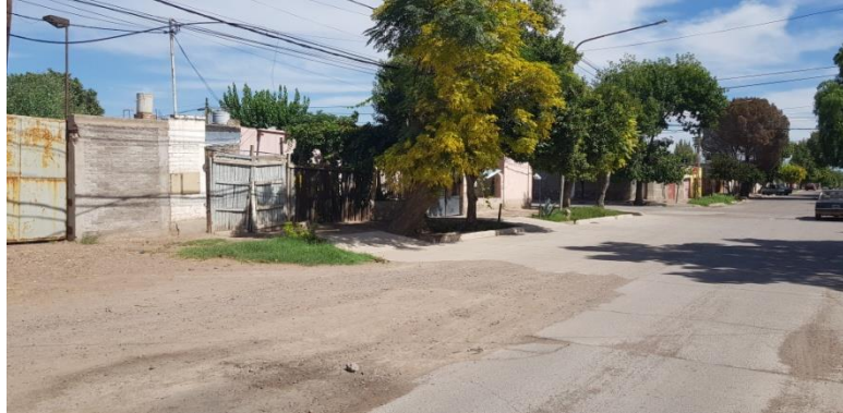
Foto N°2: Vista de la Estación Elevadora desde calle OBREROS FERROVIARIOS DE PLAMIRA.
