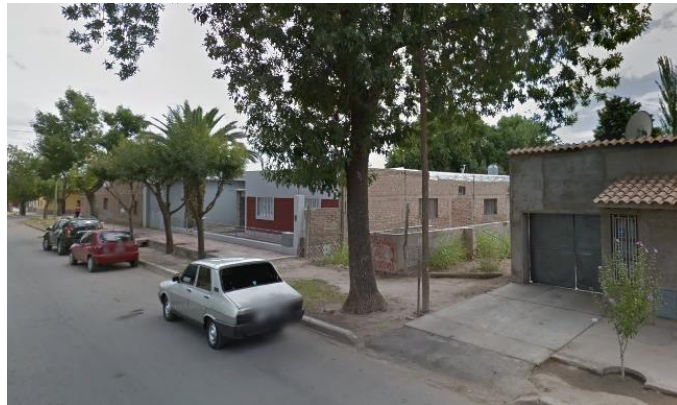
Imagen: Acequia con cruce transversal sobre calle Obreros Ferroviarios.
