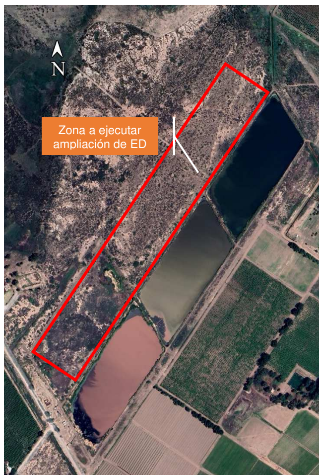
Figura 1. Foto aérea Establecimiento Depurador Palmira
