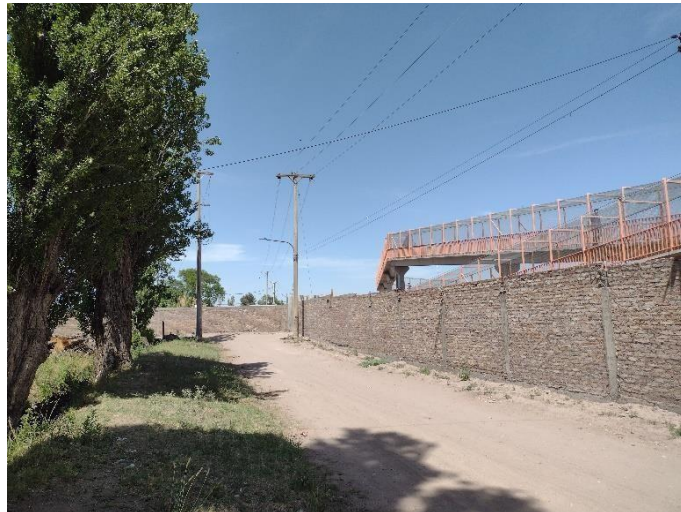
Imagen: Paredón limítrofe del FFCC y Puente peatonal.
