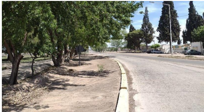
Imagen: Infraestructura vial en zona de cruce. (Donde finaliza la obra)
