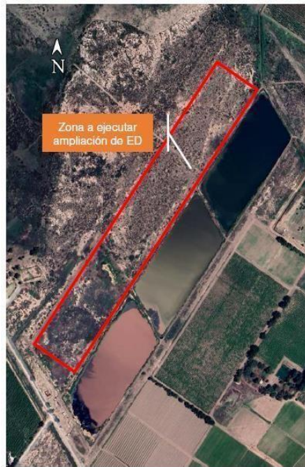
Figura 1. Foto aérea Establecimiento Depurador Palmira
