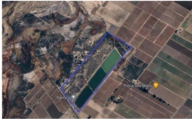
Imagen: Uso de Suelo Agrícola Zona Planta depuradora.
