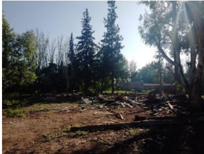
Foto N° 9: Sector oasis, con acopio de materiales de demolición.
