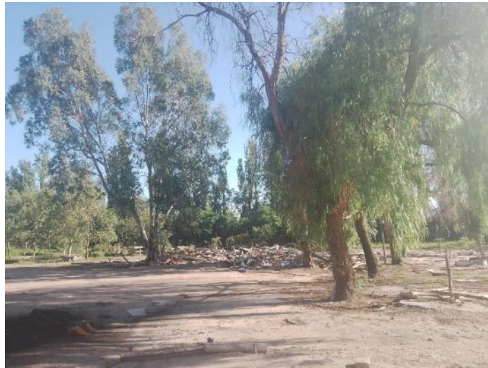
Foto N° 10: Sector oasis, con acopio de materiales de demolición.
