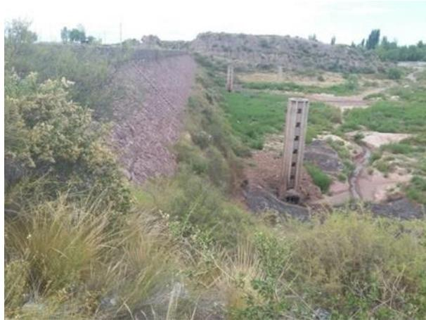
Imagen: Vista del lateral oeste del dique Papagayos, con las dos torretas de descarga de fondo.
