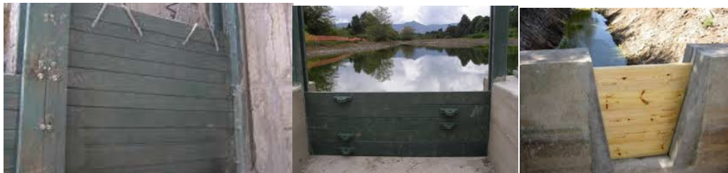
Figura 2: Compuerta conformada por etapas o tramos
